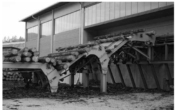
Besondere Herausforderung: Der Niveauunterschied von 4,5 m wurde mit Hilfe von zwei Entzerrstufen überwunden
